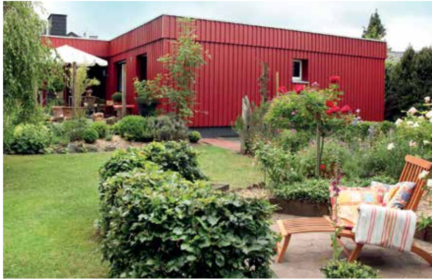
Wohnen auf einer Ebene, in großzügigen Räumen und gut gedämmt
